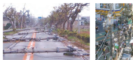
(イメージ) 災害時電柱倒壊 (出典:国土交通省ホームページ)
