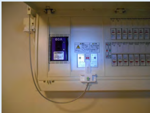
◇ヤモリ・デ・リモート利用で「ヤモリ」本体を分電盤側面部に設置したケース
