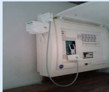
◇ヤモリ・デ・リモート利用で「ヤモリ」本体を分電盤側面部に設置したケース
