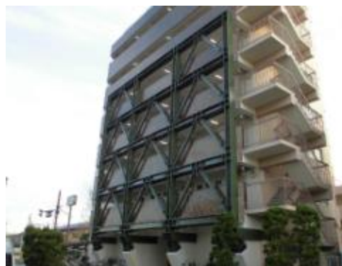
フレーム補強の事例
