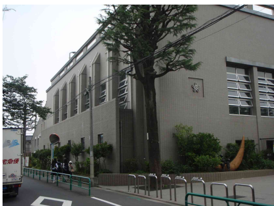
桃井第五小学校の体育館外観
