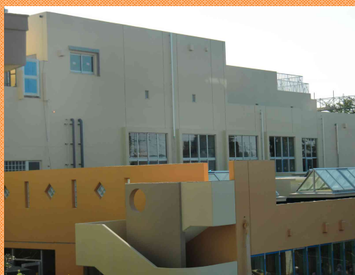
体育館棟の外観
