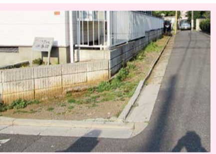
▲塀などが後退しているにも関わらず、道路が拡幅できていない箇所も、事業の対象となります
