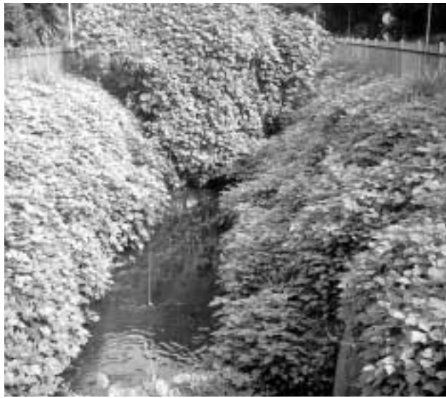
兵庫橋より上流を望む
