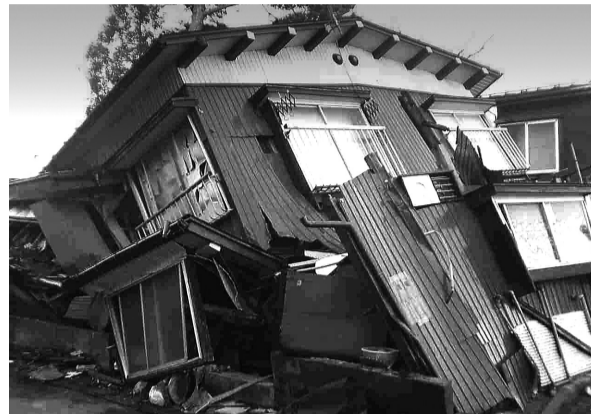
新潟県中越沖地震で崩壊した家屋 (平成19年7月、小千谷市内)
