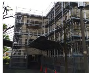
長寿命化修繕を実施した 下高井戸一丁目アパート
