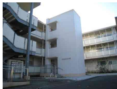
エレベーターを設置した 区営浜田山二丁目アパート
