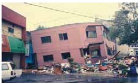
地震により倒壊した建物
