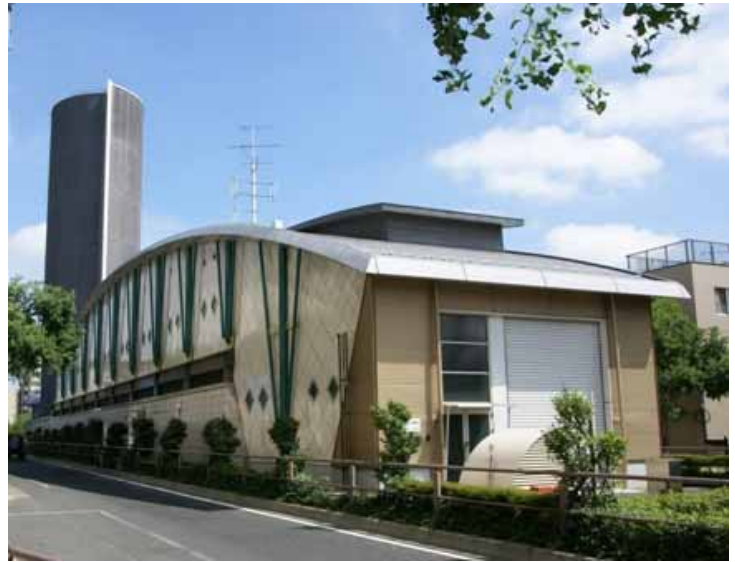
環状8号線・排気塔
