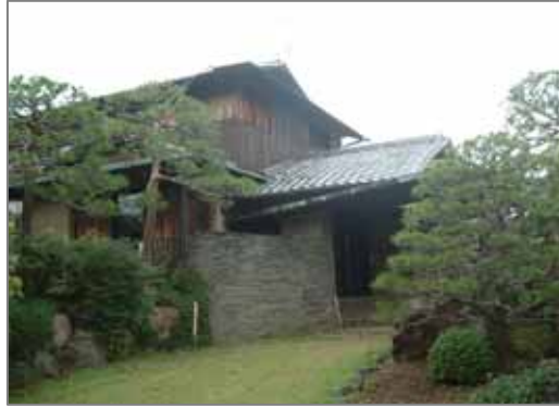
旧角川邸（角川庭園・幻戯山房）
