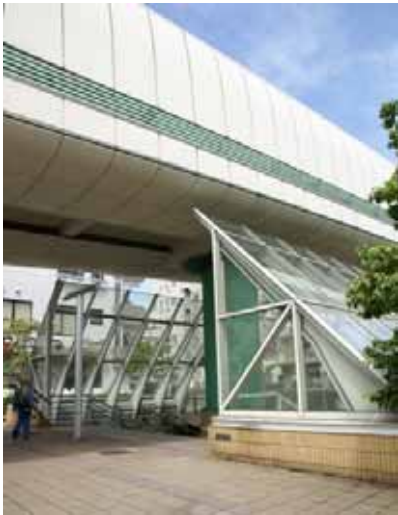
環状8号線・陸橋
