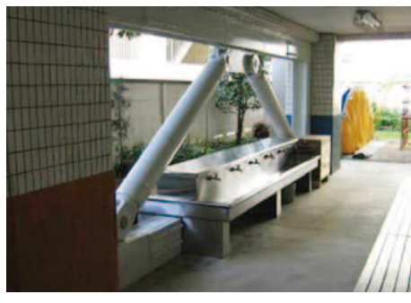
耐震補強事例(鉄骨ブレース補強)
