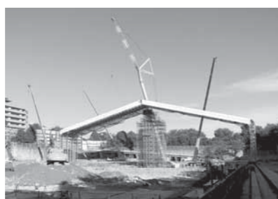
▲仮設テント組立状況
