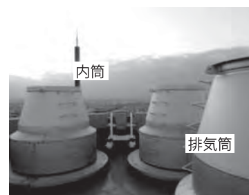
▲煙突頂部状況
