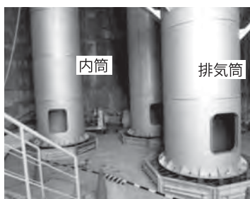
▲煙突底部状況
