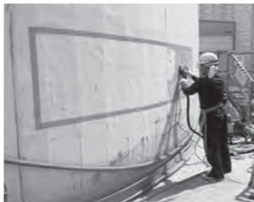
▲作業床内での補修の様子
