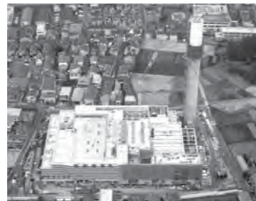
▲施工中のイメージ (練馬清掃工場建替工事)
