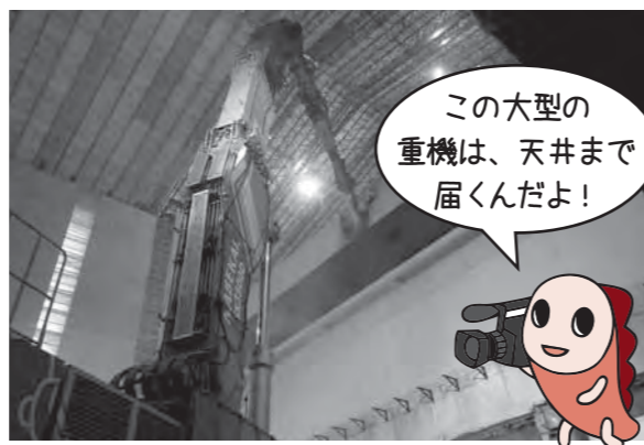
▲仮設テント内の様子
