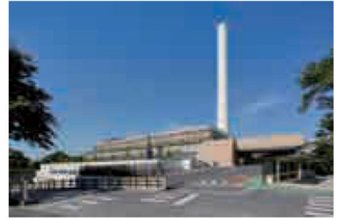
すぎなみせいそう 杉並清掃工場
