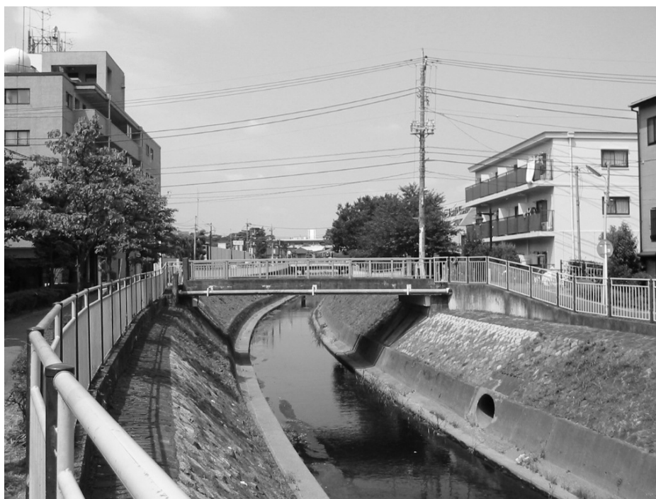
善福寺川堀ノ内橋の様子
