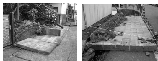
(ブロック塀の倒壊の事例)
