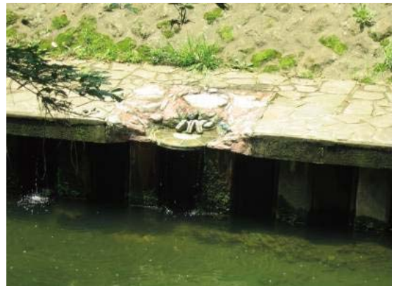
御供米橋周辺の湧水
