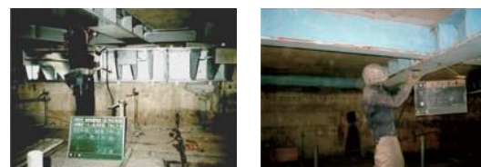
落橋防止システムの設置
