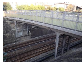
東睦橋（跨線橋）
