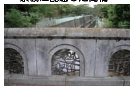
塚山橋(平成元年架設 神田川)
