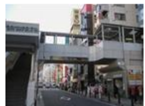
荻窪西口連絡橋（跨道橋）
