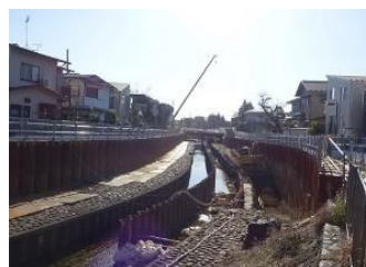
現在進められている 河川整備の様子（神通橋上流）
