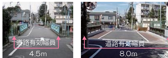
整備前 整備後 / 弁天橋(平成21年度整備 神田川)
