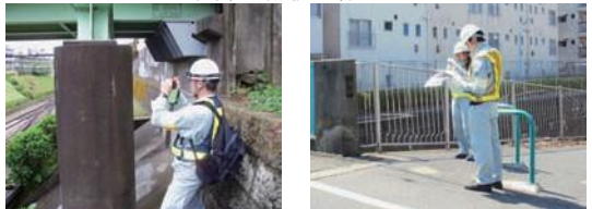
異常時点検の様子
