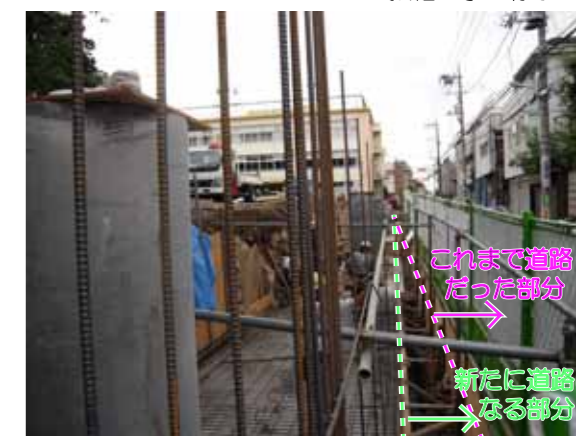
↓ 拡幅工事の様子
