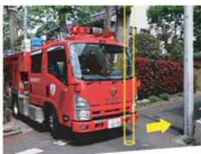
電柱の移設で緊急車両の通行が可能となった例
