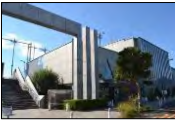
・上井草スポーツセンター
