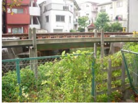
線路で分断された遊歩道
