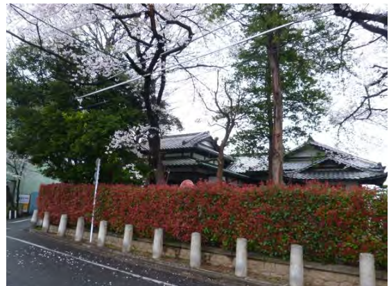
天理教敷地周辺から見た荻外荘移築部分
