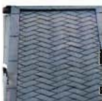
網代(あじろ)模様 模様は、小さな銅版を噛み合わせて作る、手の込んだもの。
