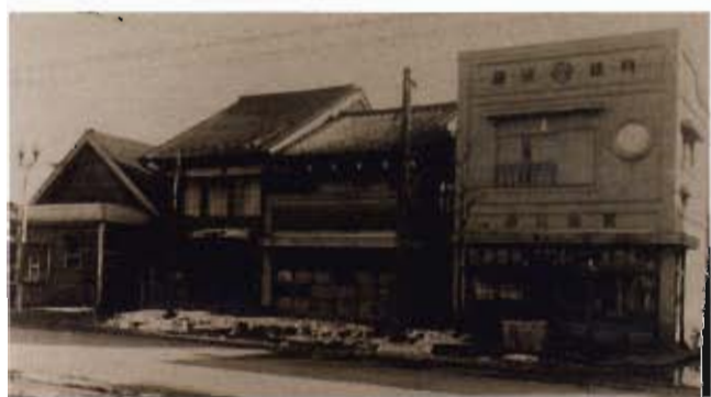
昭和19年の青梅街道。看板建築と出桁造りの店舗が並ぶ。(田端交番付近 成田東四丁目)
