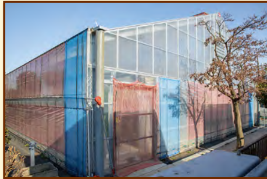
▲強度が高い鉄骨ハウスは、雪や大型台風にも負けなかった
