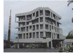
▲熊本地震での宇土市役所の倒壊
