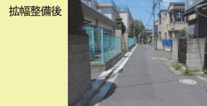
▲狭い道路の拡幅整備の事例
