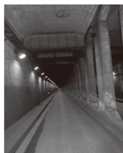
▲地下道路内部
