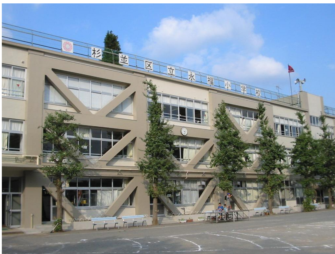
外付け耐震補強工事
