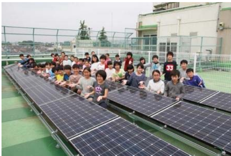
東田小学校の屋上に設置した太陽光発電パネル
