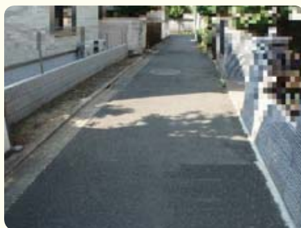
拡幅整備工事前
