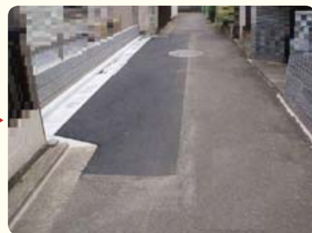
拡幅整備工事後
