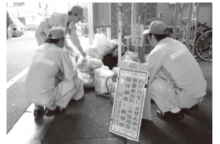
適正に貼付されているか調査中
