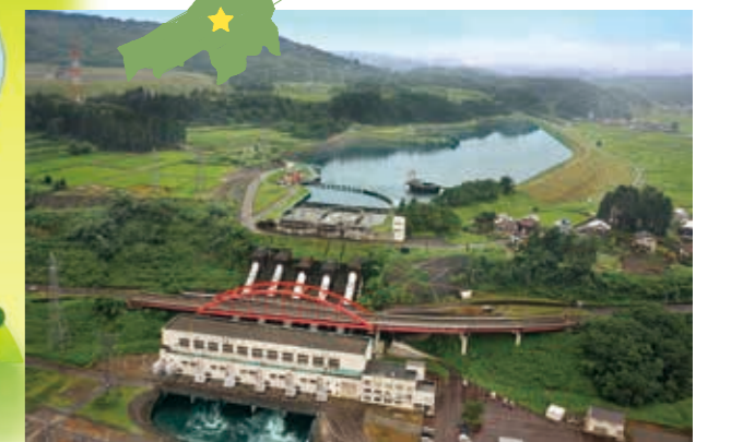
▲調整池にためた水を朝夕のラッシュ時に合わせて発電所へ流します。
