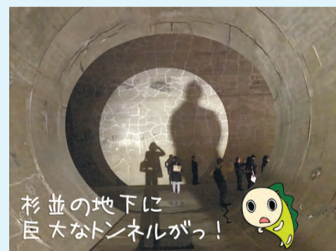
▲神田川・環状七号線地下調節池
