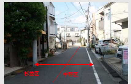
▲防災生活道路②の様子
