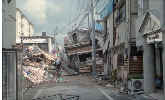
阪神淡路大震災で建物の倒壊で塞がった道路
