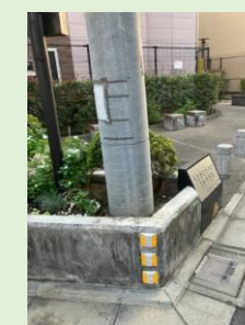
◀ポケットパーク内に電柱を配置し、道路へ突出させない工夫をしています
