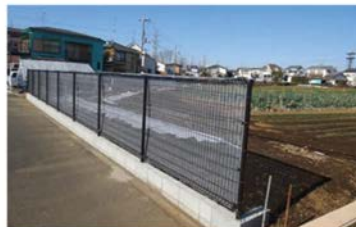
土留め、フェンスの設置
