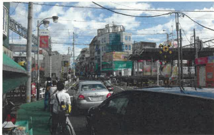
踏切の状況（上石神井第1号踏切道）
