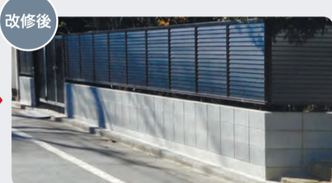
▲既存ブロック塀を全て撤去し、軽量フェンスに改修
