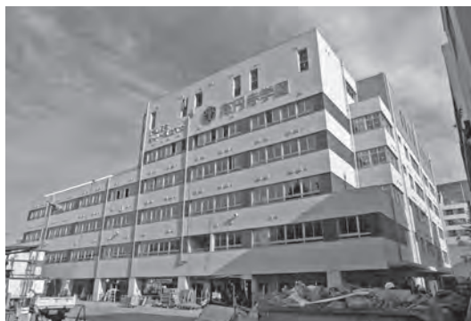
高円寺学園建設工事
