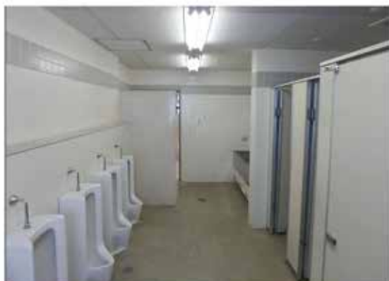
男子トイレ 改修前
