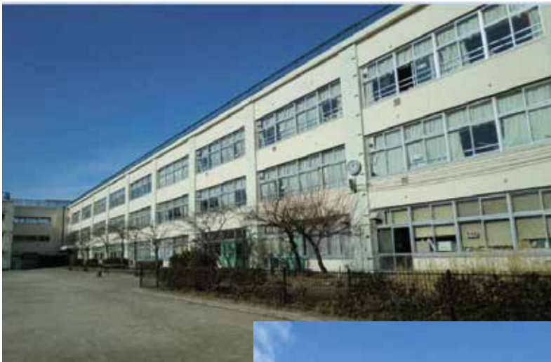
改築前 (高井戸第二小学校)
