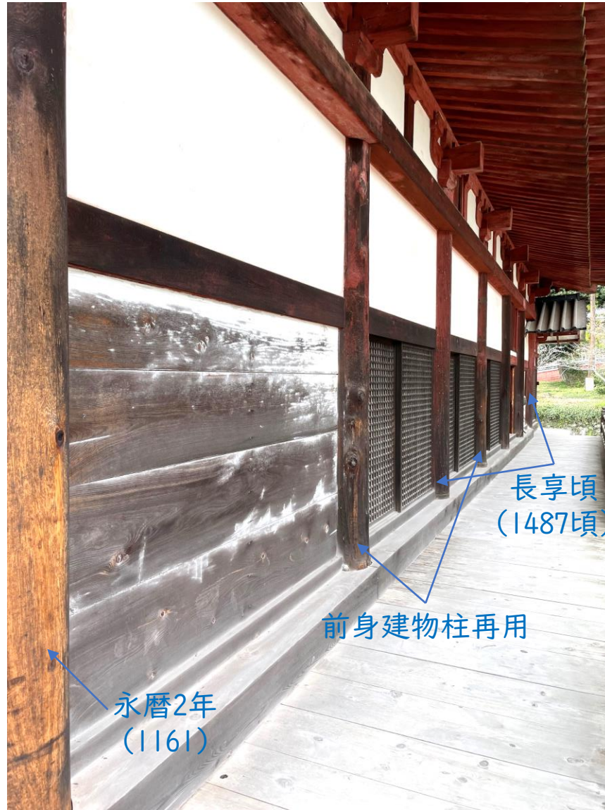
北面外壁写真
