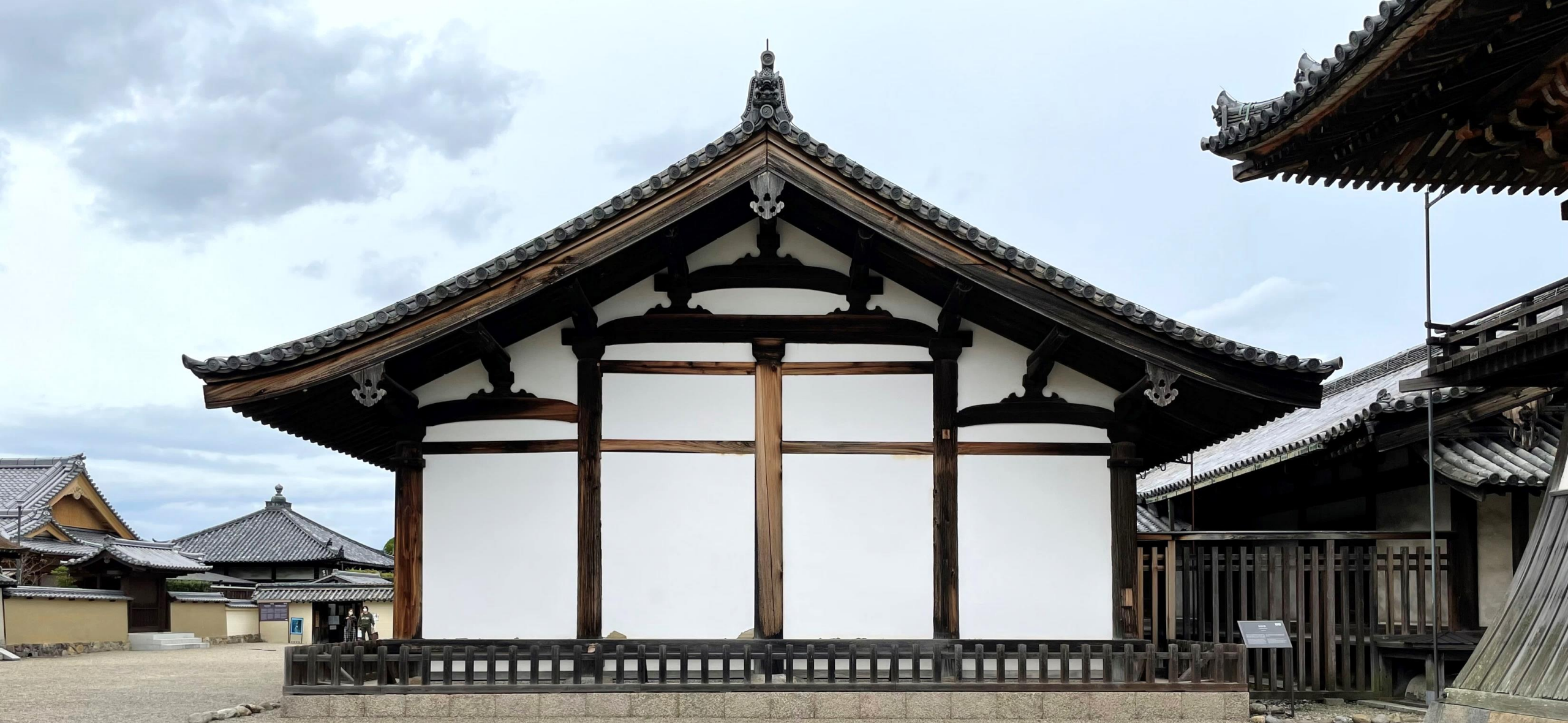
伝法堂西面の写真。前頁現状平面図にみられるように、中央の柱一本が慶長期に新材に取替られている。
