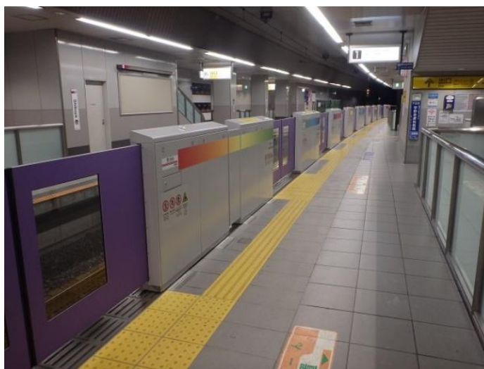
京王井の頭線渋谷駅のホームドア設置例
