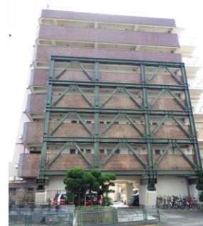
マンションの耐震改修事例
