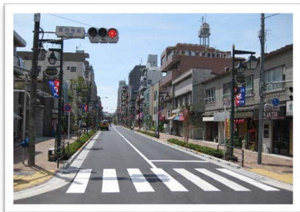
拡幅整備後のイメージ
