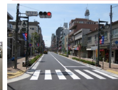
（事例写真）拡幅整備
