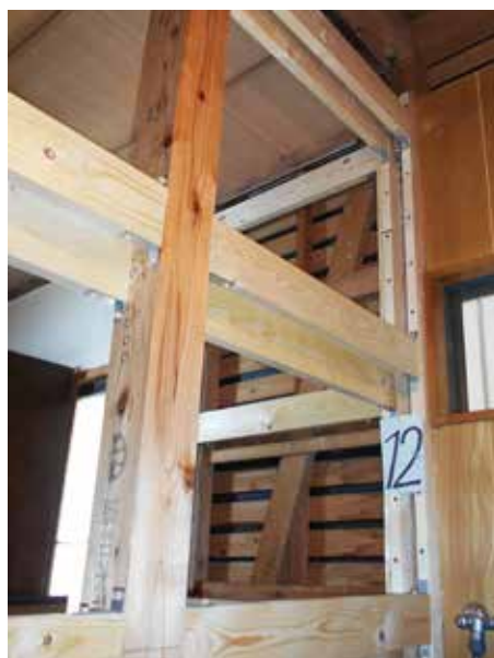
木造住宅の耐震補強例
