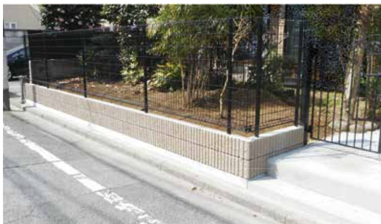
ブロック塀等施工前後
