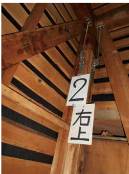
木造住宅の耐震補強例
