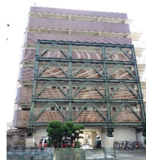
マンションの耐震改修事例
