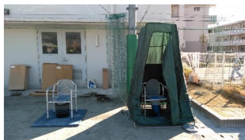
マンホールトイレ設置
