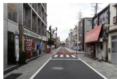
無電柱化の整備例 (特別区道 2101-1 号線)
