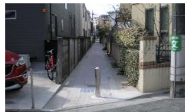
旧水路敷の整備例
